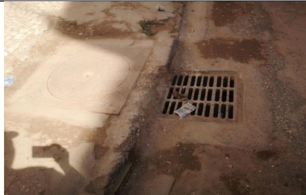
Existence de réseaux concessionnaires X : 236040.47 ; Y : 1625919.55
