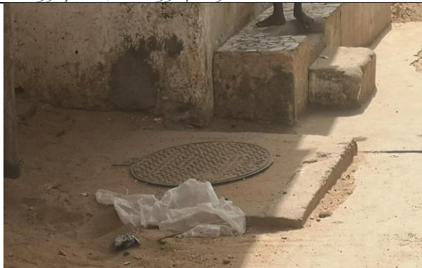
Existence de réseaux concessionnaires X : 240334.45 ; Y : 1634017.53
