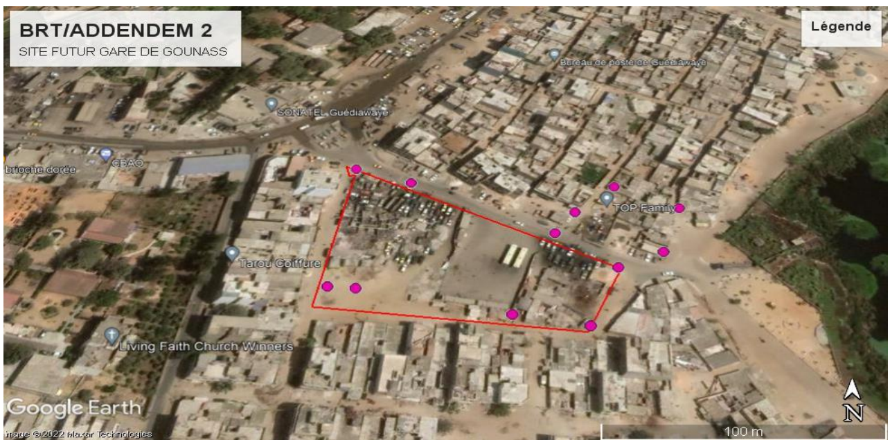
Figure 4 : Vue d'ensemble du site de relocalisation des terminus AFTU et DDD de Médina Gounass
